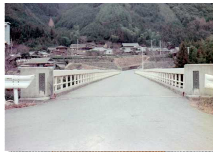
完成時の久保井戸橋
