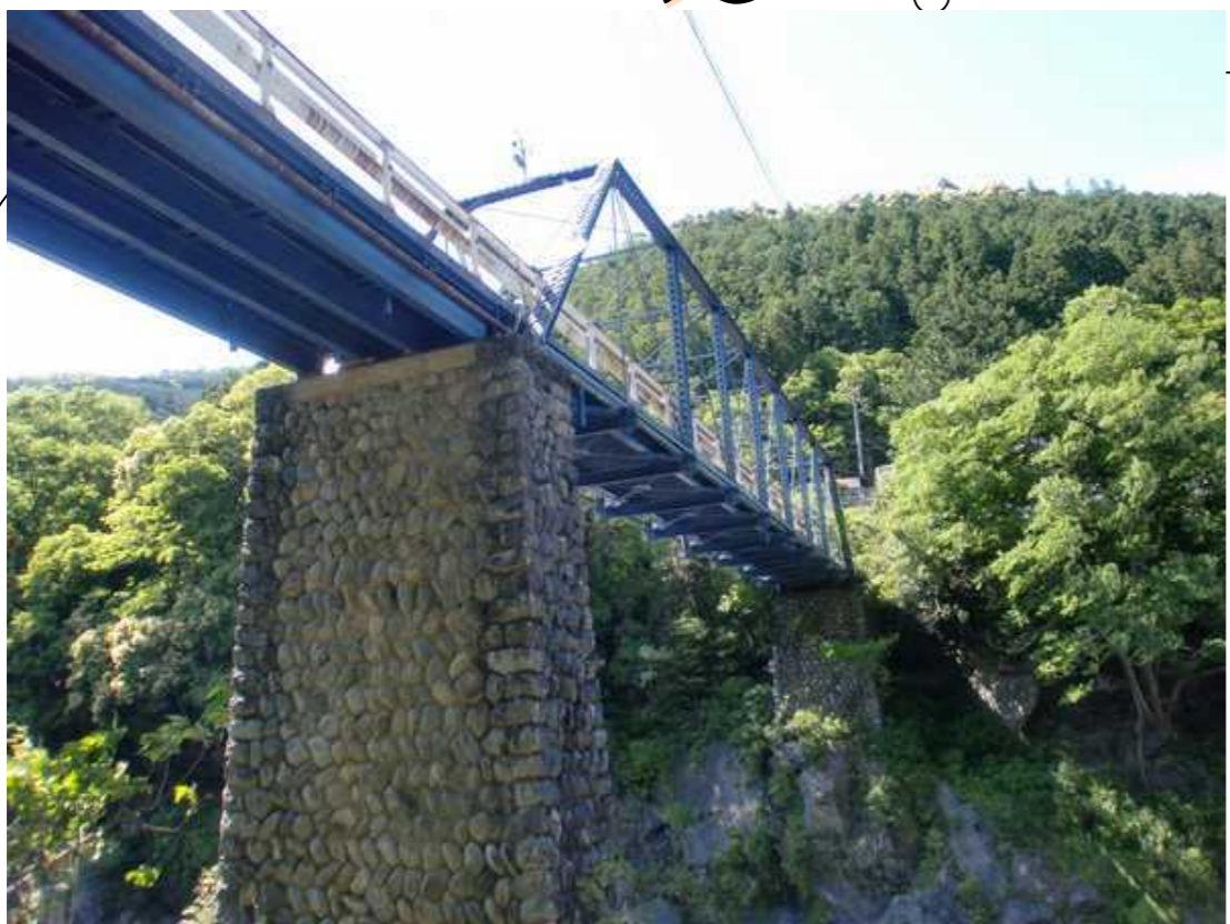
南地内から見た領内橋
