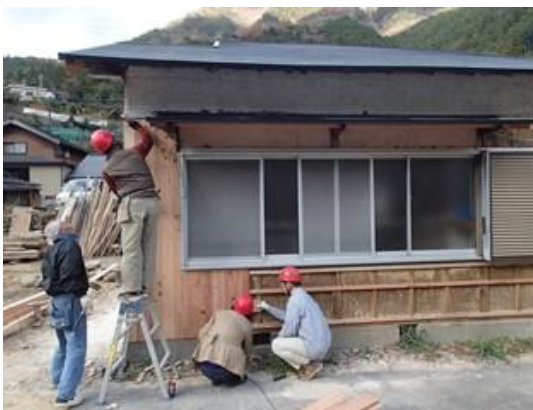
外囲い板を張る
