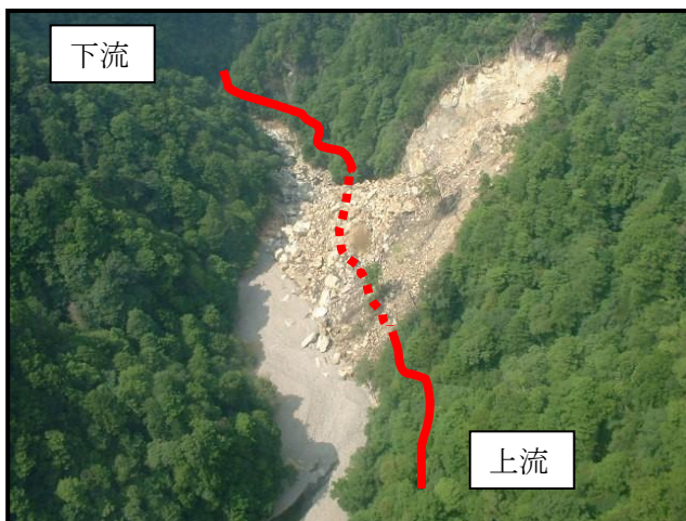
光滝周辺の崩落地
