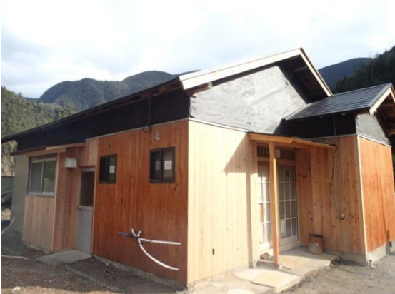
張り替えた外壁
