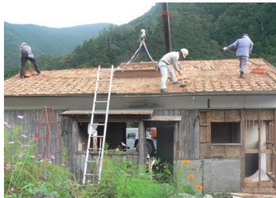
瓦を降ろす作業
